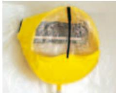
避免弄髒冷氣機周圍及損傷，使用專門的防護罩作保護。
