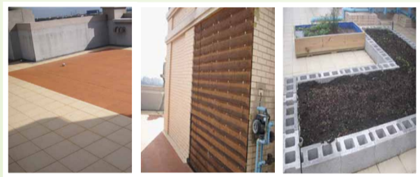
左起：防水處理、設植生綠牆、蔬菜培植園動工
