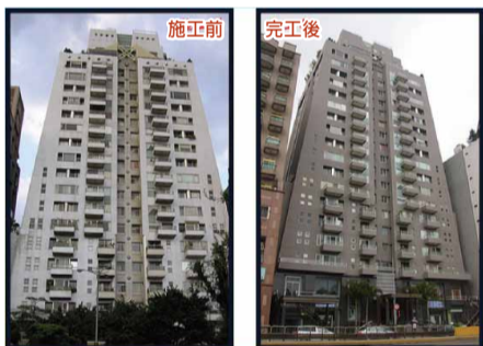
位於信義路上的「愛非爾」社區外牆拉皮前後對照圖
