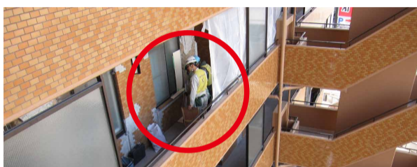
NIHON HOUSING人員(紅圈處)於受災區域進行現場勘查及修護
