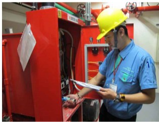
眾鼎機電工程處提供完善、多樣化的社區修繕服務
