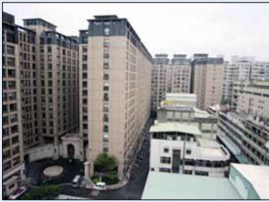
工業住宅旁廠房林立，易影響生活品質(圖二)
