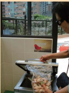
「一般垃圾」與「廚餘」屬較易產生惡臭的垃圾，因此在空間上，1F的丟棄孔有直通B1F的管道設計。住戶所丟棄的一般垃圾和廚餘，會順著管道落入B1F冷藏室的收納桶中，收納桶則採移動式推車規劃，便利垃圾清運商與清潔人員至B1F冷藏室快速清離社區，且不干擾住戶平日的居家動線。
