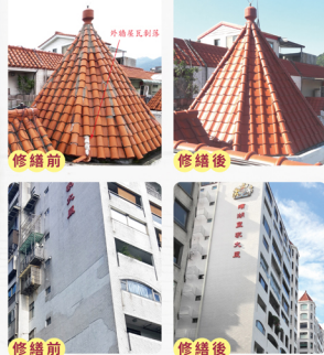
修繕前 修繕後
