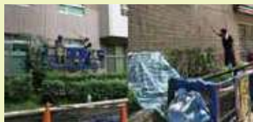
步驟2 磁磚打診檢測
