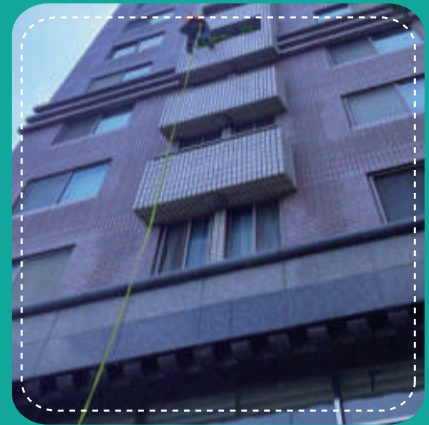
▲ 外牆健檢工程施工情形
