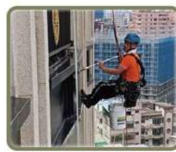
玖原富都外牆清洗工程
