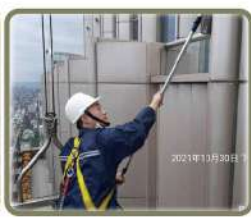
遠雄金融中心外牆清洗施工
