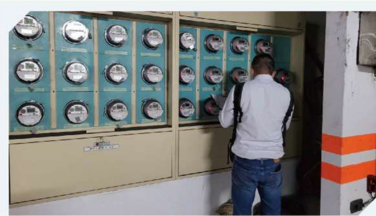
工程師實地勘察
