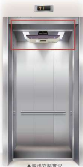
▲電梯安裝實況
