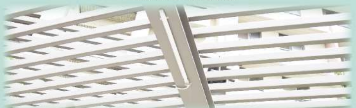
▲公共走廊改接應式照明
