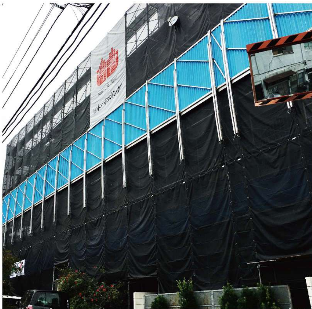
▲ Nihon Housing於日本施行大規模修繕之現場
